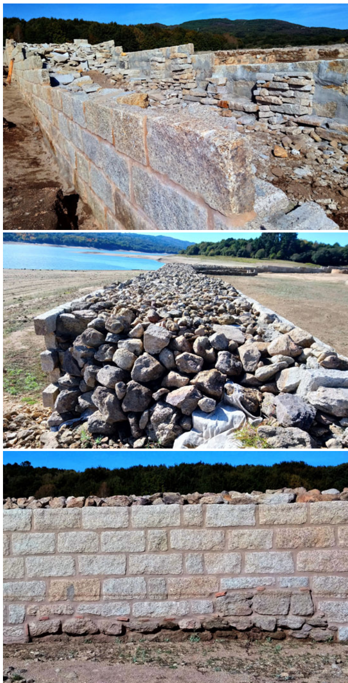
Fig. 17. Reconstrución da muralla do campamento mediante pequenos perpiaños nos paramentos externos e cachotaría e cascotes de refugallo no recheo; os paramentos orixinais conservados foron diferenciados mediante fragmentos de tegula . Arriba, muralla SO en proceso de reconstrución; En medio, muralla SL xa reconstruída; Abaixo, paramento exterior orixinal e reconstruído na muralla SL [fotos M. Lago Cerviño, novembro 2019]
