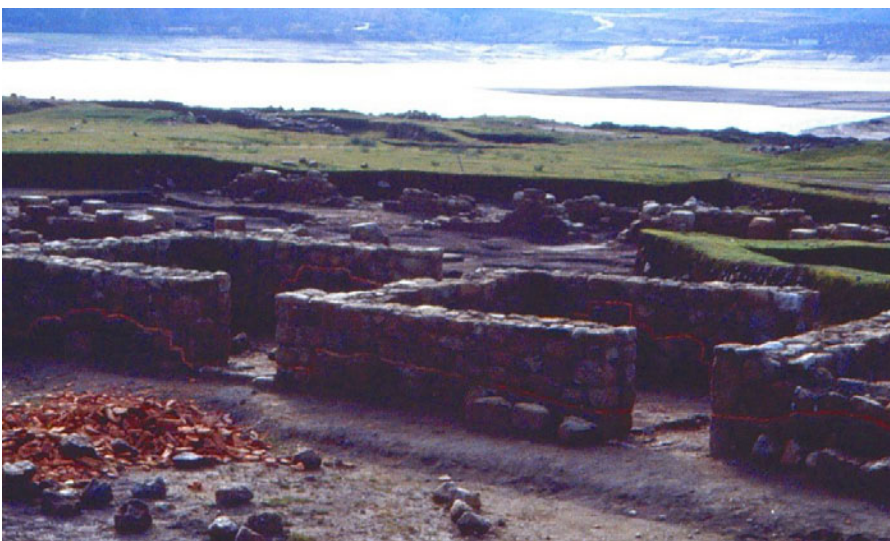
Fig. 15. Muros de cachotería pétreo, orixinais e reconstruídos, na esquina sur do barracón num.2, diferenciados mediante o uso dunha liña continua de tellas e ladrillos como elemento separador (decembro de 1987) [foto F. Pérez Losada]
