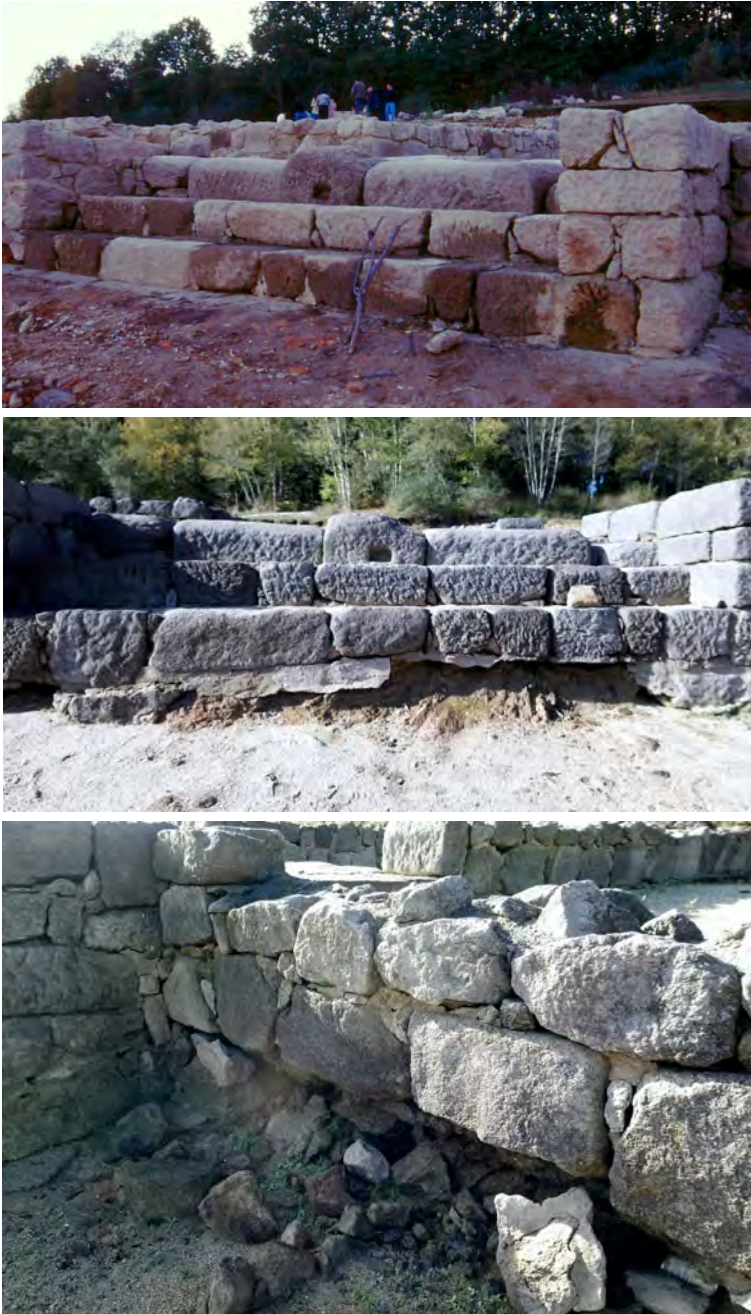
Fig. 22. Fachada principal (NL) do edificio da mansio , amosando un grao de afección moi severo, incluso crítico, pola erosión do encoro. Arriba, estado de conservación das escadas de entrada ao edificio en outubro de 1996, recen concluídas as obras de consolidación e restauración [foto F. Pérez Losada]. En medio, estado de conservación da mesma entrada en novembro de 2019, cos alicerces totalmente erosionados polas augas [foto M. Lago Cerviño]. Abaixo, paramento do muro a carón da entrada, totalmente erosionado e disgregado polo encoro, tanto a parte orixinal como a reconstruída, en risco de colapso inminente [foto M. Lago Cerviño, novembro 2019]
