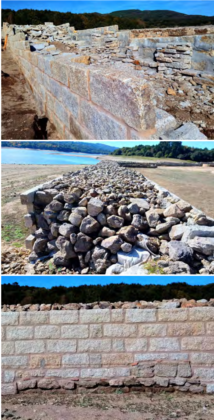
Fig. 17. Reconstrución da muralla do campamento mediante pequenos perpiaños nos paramentos externos e cachotaría e cascotes de refugallo no recheo; os paramentos orixinais conservados foron diferenciados mediante fragmentos de tegula . Arriba, muralla SO en proceso de reconstrución; En medio, muralla SL xa reconstruída; Abaixo, paramento exterior orixinal e reconstruído na muralla SL [fotos M. Lago Cerviño, novembro 2019]
